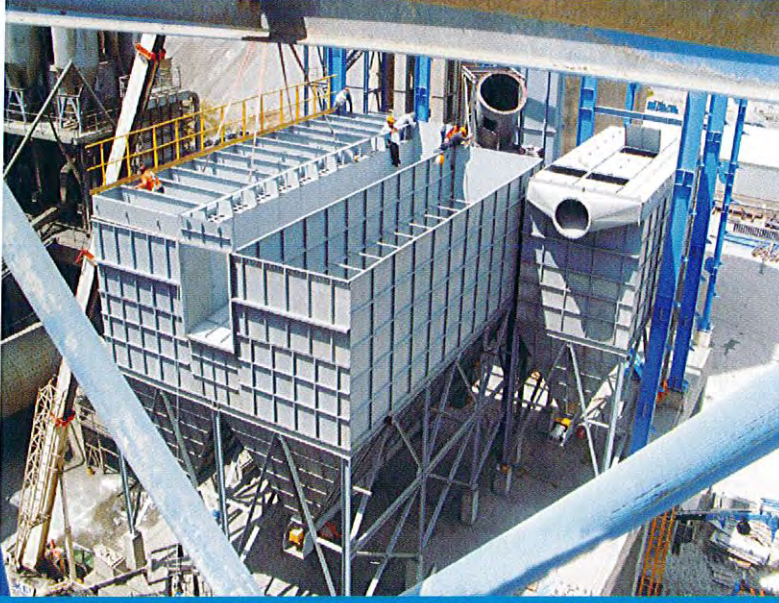
Çimento Değirmeni Filtresi Montajı / Erection of Cement Mill Filter
