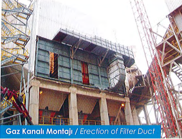
Çimento Değirmeni Filtresi Montajı / Erection of Cement Mill Filter
